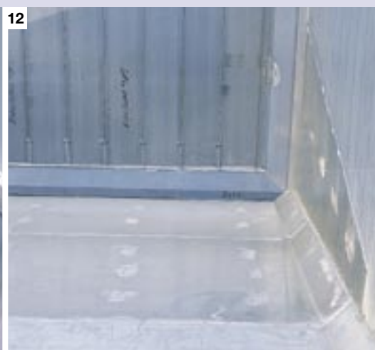
12. Chapas para piso y laterales en acero inoxidable.
