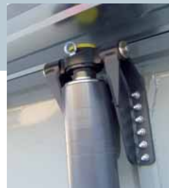
Encastrement de la tête du vérin pour plus de stabilité.
