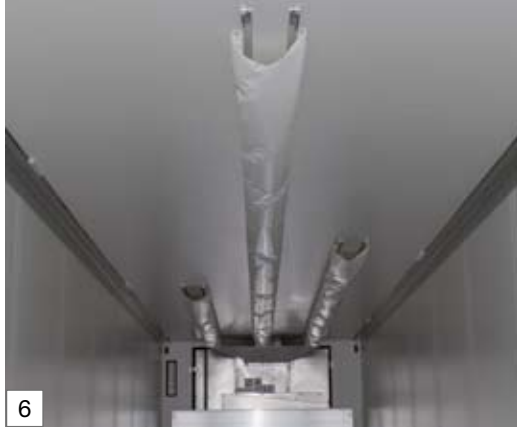
Gaines de ventilation flexibles
