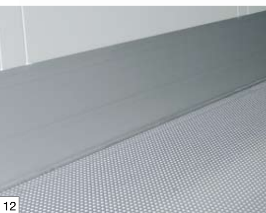
Plancher en tôle striée aluminium soudé aux plinthes aluminium
