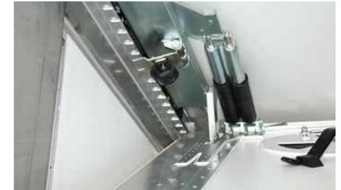
Die Abstimmung von Gewicht und Federkräften ist für eine sichere und einfache Bedienung der Trennwand optimiert.
