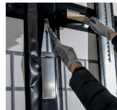
**Einfach sicher:** Mit einem einfachen Hebelmechanismus werden die Supporting Bars\*\* am Dachprofil und an der Anschlagleiste stabilisiert.
