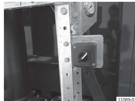
Odvojeni prekidač za osvetljenje unutrašnjosti sanduka na nosaču svetla/pneumatike
